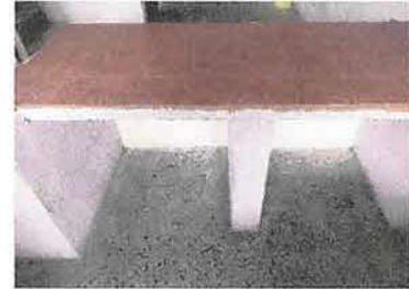
Foto 2: COLOCACIÓN DE AZULEJO AREA DE COCINA
