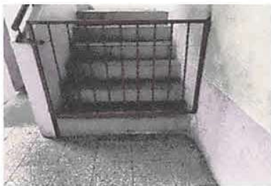
Foto 5: INSTALCIÓN DE REJA
