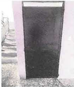
Foto 3: PINTURA DE LAS PUERTAS DE LOS BAÑOS
