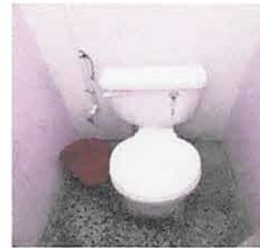
Foto 4: SUSTITUCIÓN DE SANITARIOS
